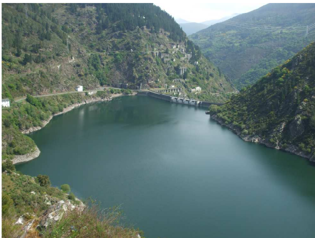
La diga, vista dall'altra parte della valle salendo verso il paese di Grandas De Salime
